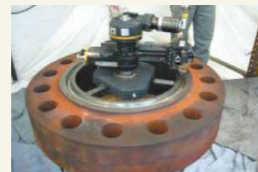
ガスケット溝の補修
