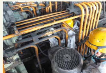
鍛圧機器油圧配管の 点検・補修
