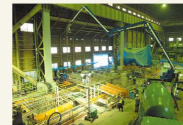
機械基礎工事
