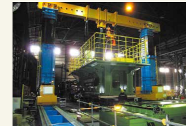
大型設備据付
