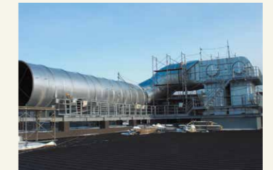
大型ダクト敷設工事
