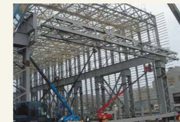
工場建屋建設工事
