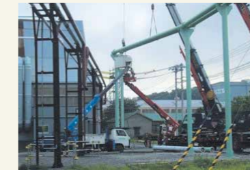
配管敷設工事
