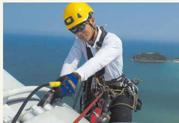
ロープワークを活用した 風力発電設備点検
