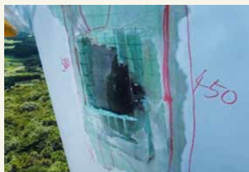
落雷によるブレード 損傷調査・補修
