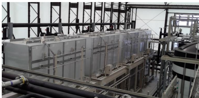
定置用大型タンク (水素貯蔵量: 3,500Nm 3 )
